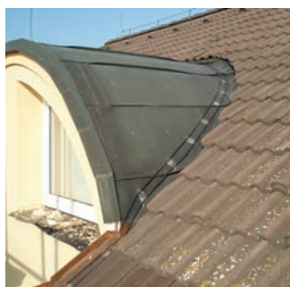
instalace topných kabelů u atypického střešního okna
