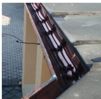
instalace topných kabelů v okapu
